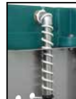
Variante heizbar, Anschluss an Stichleitung mit Frostschutz-Heizleitung am Ventil
