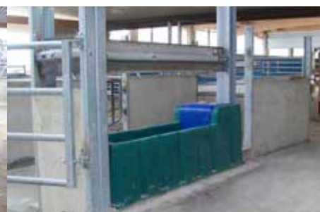
Variante I: 1x MAXIFLOW-Ventil (an Stichleitung mit Frostschutz- Heizleitung 24 V, 20 W, 2 m), 1x Zusatzheizung 24 V, 180 W
